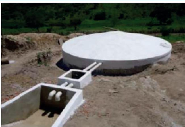
**Figura 11.** Ilustração da cisterna do tipo enxurrada. Fonte: ASA 2017.
