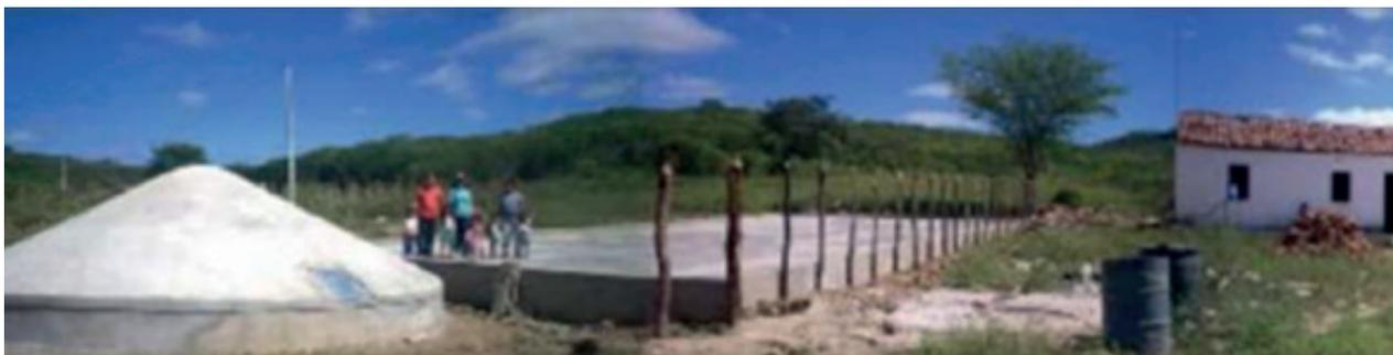
**Figura 10.** Ilustração da cisterna do tipo calçadão. Fonte: ASA 2017.
