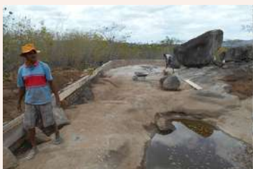
Tanque de Pedra
