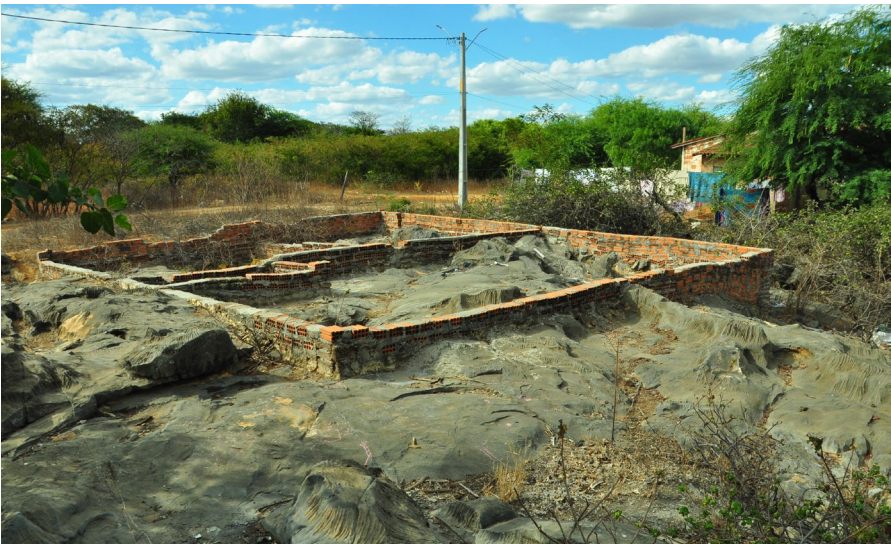
Fundação de construção abandonada sobre lajedo carbonático, Lapão-BA. Foto: Ricardo Galeno Fraga de Araújo Pereira.
