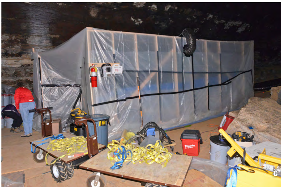
(A), (B) e (C) Aspectos de canteiro de obras de implementação de infraestrutura, no interior da Mammoth Cave , com estruturas temporárias em plástico transparente para proteção de feições da caverna ou para evitar a disseminação de contaminantes. Mammoth Cave National Park , EUA. FOTOS: Luciana Alt.
