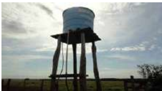
Figura 70 - Reservatório de água.
