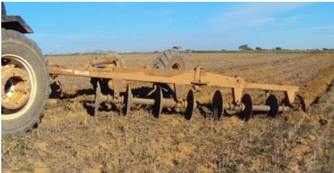
Figura 27 - Construção de terraço com terraceador
