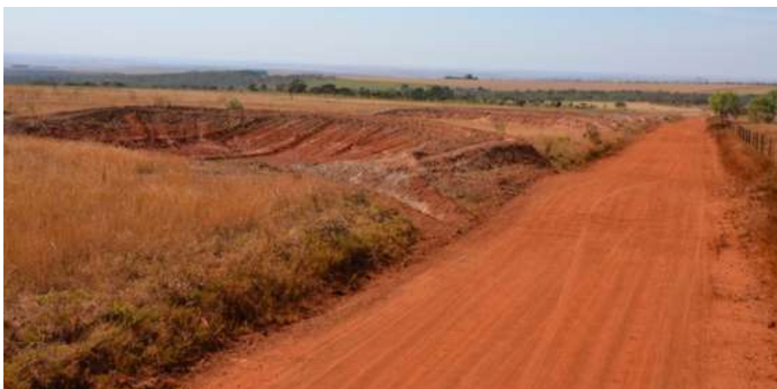
Figura 29 - Construção de caixas de retenção de água das chuvas.
