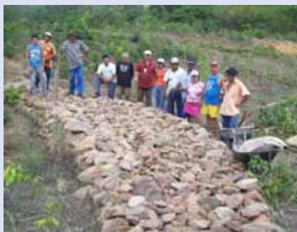
Foto 02 - Atividade coletiva para construção de barragem sucessiva.
