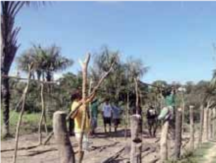
Foto 01 - Construção de viveiro.
