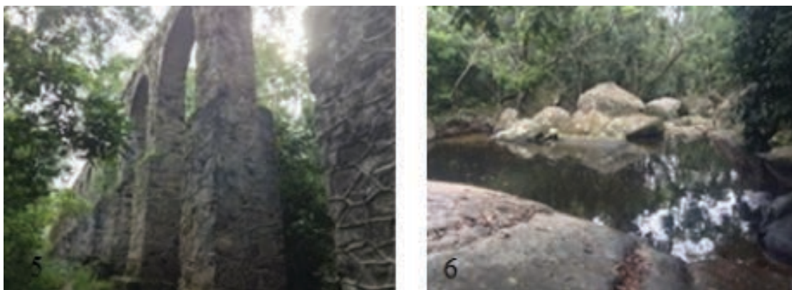
Figuras 5 e 6 – Aqueduto (detalhe: arcos) e Poção.
