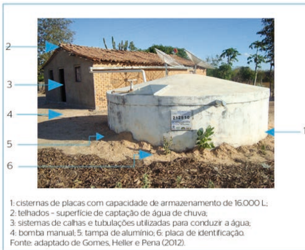
Figura 2 – Sistema de captação de água de chuva do P1MC.
