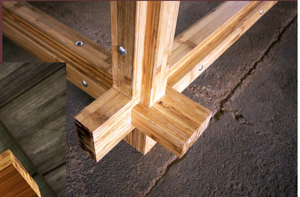
União estrutural da parte inferior em BaLC.
