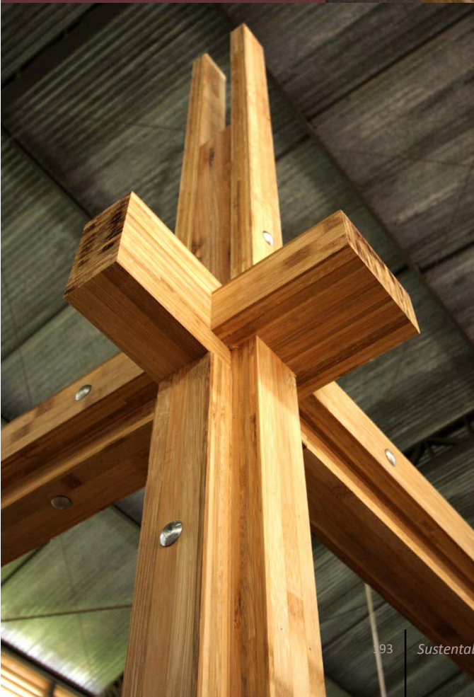
União estrutural da parte superior em BaLC.
