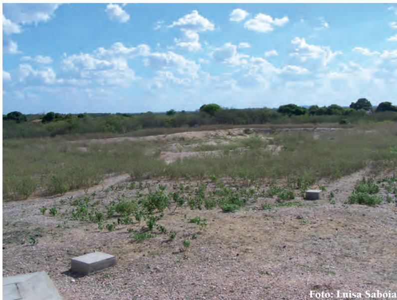
Sistema de tratamento de resíduos desativado de Abatedouro
