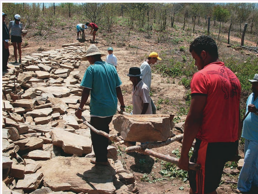
Foto 32.1 – Transporte manual das pedras pelos assentados, visto de jusante da ombreira esquerda. Observam-se também alguns assentados visitantes.
