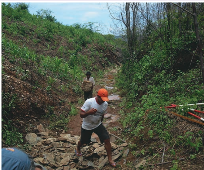
Foto 36.19 – Assentados transportando manualmente as pedras para a obra.
