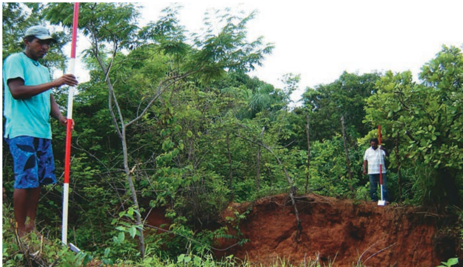
Foto 09 – Marcação do eixo da BBZ – 02, pelo alinhamento dos piquetes A e A' situados nas duas margens e perpendicular ao trecho do riacho. Observa-se o balizeiro da margem direita (o mais próximo na foto) e da margem esquerda (o mais distante) ao lado da cerca.
