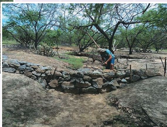
Foto 31b – A última pedra do coroamento da BBZ, vista do meio do riacho a montante. Observa-se a parede de montante a prumo e nivelada pelo topo das estacas do arco de montante. Foto: Instituto Cactos
