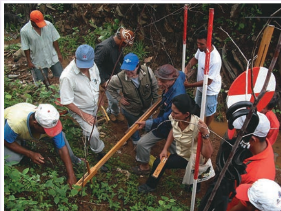
Foto 36.4 – Locação dos dois pontos de sangria, B e B', em ambas as margens, na cota 1, vista de outro ângulo. No presente caso, empregou-se a régua e "nível de pedreiro", face à estreiteza do vão da BBZ, dispensando-se o nivelador de alvo.
