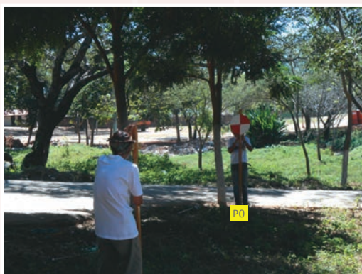
Fotos 7.0 – Locação (marcação) de curva de nível
