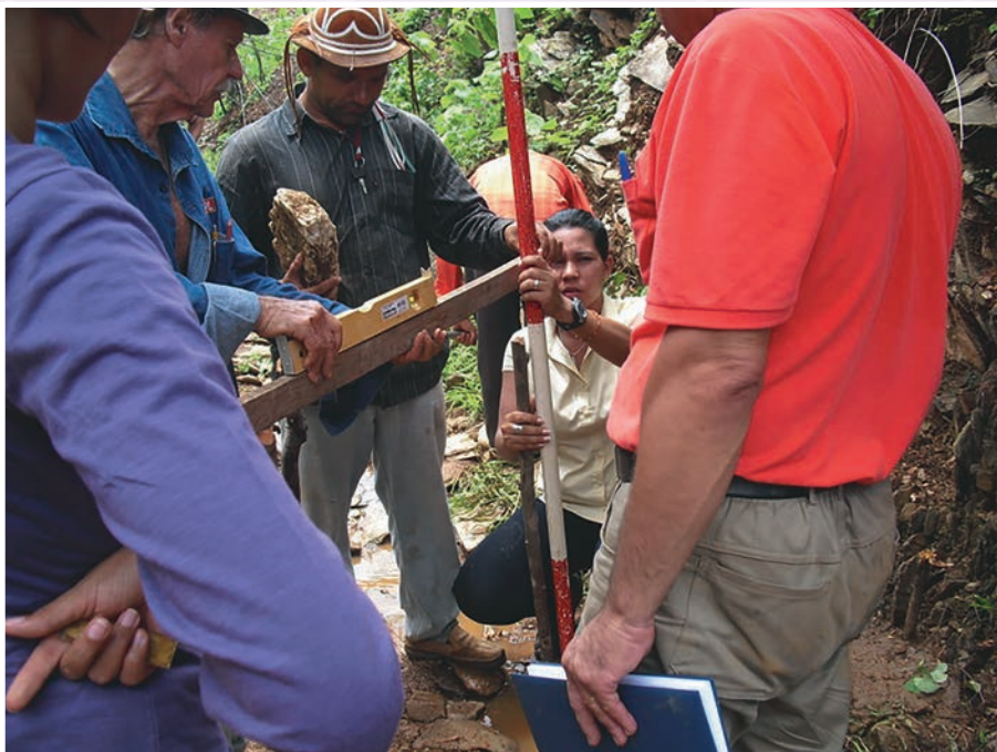
Foto 36.10 – Marcação das estacas do arco de jusante, por estacas que substituem os piquetes provisórios e cujos topos correspondem às cotas de sangria, os pontos B e B'. No presente caso, face ao pequeno vão da BBZ, utilizou-se régua e “nível de pedreiro”, dispensando o nivelador de alvo.
