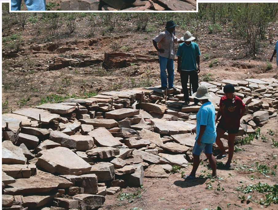
Foto 32.3 – BBZ em obras, mureta e coroamento já concluídos, o arraste da saia (arrimo) em conclusão, vista da ombreira direita a jusante. Observe-se a mureta nivelada e os topos das estacas do arco de jusante. O seu formato em Arco Romano transfere as pressões hidráulicas exercidas no barramento para as ombreiras, dando a máxima estabilidade à obra, norma estabelecida por Arthur Padilha – ex-diretor do Departamento Nacional de Obras contra as Secas (Dnocs) – “o pai do Sistema BBZ”.
