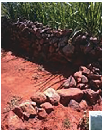
Foto 05 – A foto anterior vista de outro ângulo. Observe-se a sinuosidade do trecho em construção recente – de menor altura – acompanhando a curva de nível do terreno. Crédito: Cerlit – PE
