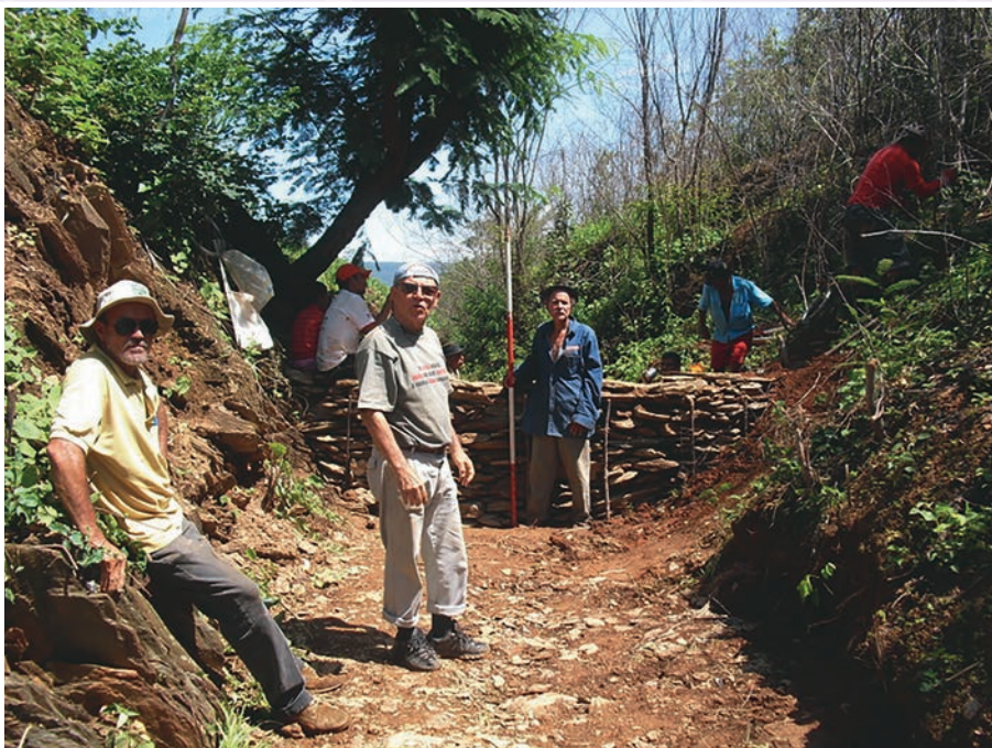
Foto 36.22 – BBZ concluída, vista de montante. Observa-se o seu coroamento nivelado pelos topos das estacas do arco montante e os interstícios para filtragem das águas turvas, retendo a montante o barro, a lama e o limo, formando as férteis minivazantes. O seu formato em Arco Romano transfere as pressões hidráulicas exercidas no barramento para as ombreiras dando a máxima estabilidade à obra, norma estabelecida por Arthur Padilha – ex-diretor do Dnocs – “o pai do Sistema BBZ”.
