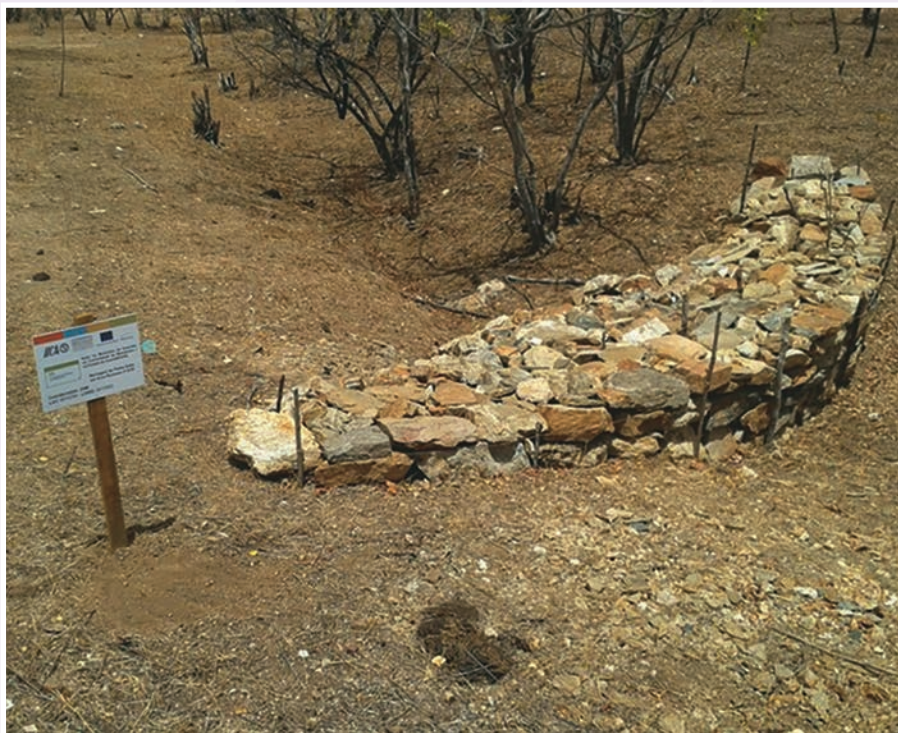
Foto 34 – BBZ concluída, vista da ombreira esquerda, a montante, de outro ângulo. Observa-se o seu coroamento nivelado e os interstícios para filtragem das águas turvas, retendo a montante o barro, a lama e o limo, formando as férteis minivazantes. O seu formato em Arco Romano transfere as pressões hidráulicas exercidas no barramento para as ombreiras dando a máxima estabilidade à obra, norma estabelecida por Arthur Padilha – ex-diretor do Dnoacs – “o pai do Sistema BBZ”.
