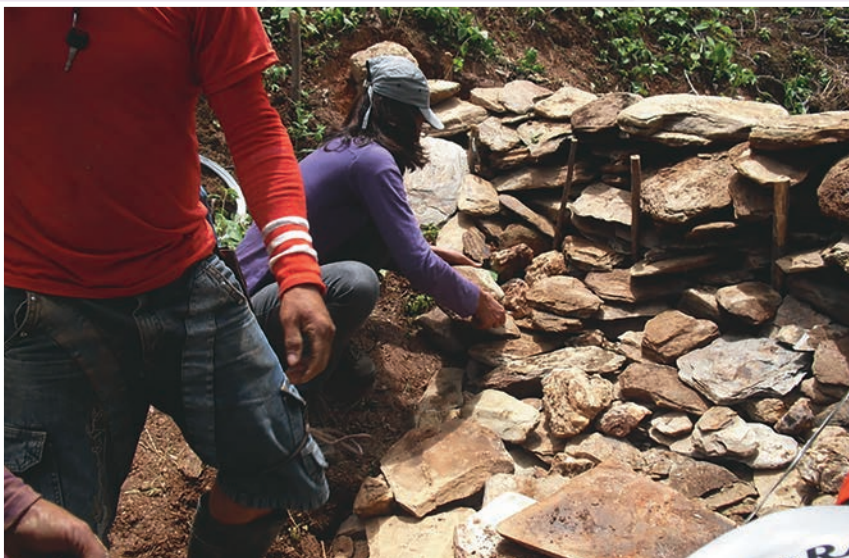
Foto 36.20 – Elevação do corpo da BBZ, vista de jusante. Mureta e o arraste da saia em conclusão. Observam-se algumas estacas do arco de jusante, já perto da ombreira direita e os interstícios entre as pedras que funcionarão como filtro, retendo, a montante, o barro, a lama e o limo em suspensão nas águas turvas, formando as férteis minivazantes.
