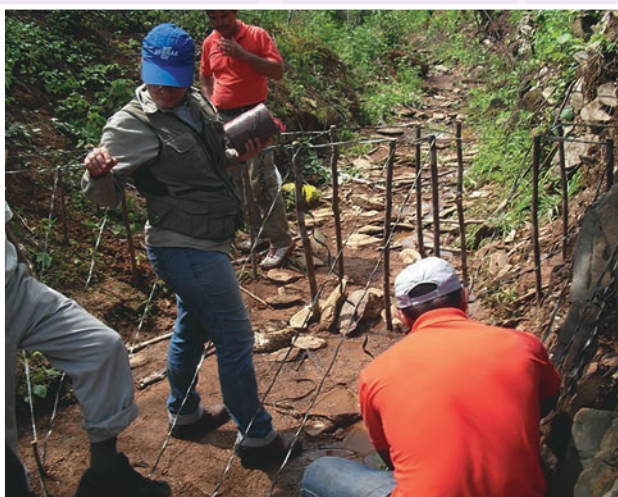
Foto 36.12 – Marcação do arraste da saia da BBZ, vista de outro ângulo. Observam-se as estacas niveladas dos arcos jusante e montante. Um assentado mede a altura da estaca – no caso um 1,00 m – e alinhado, com o centro geométrico da obra, marca o seu arraste, no caso duas vezes a altura, face ao talude adotado, ou seja, 2,00 m. Vulgarmente o arraste da saia da BBZ é denominado “arrimo”.
