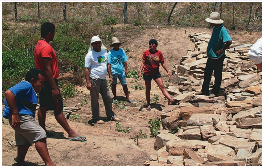
Foto 32.6 – BBZ já concluída, vista da ombreira esquerda a jusante. Observa-se o talude 2:1, do arraste da saia da BBZ, o consultor Geraldo Leal e os seis assentados construtores da obra.
