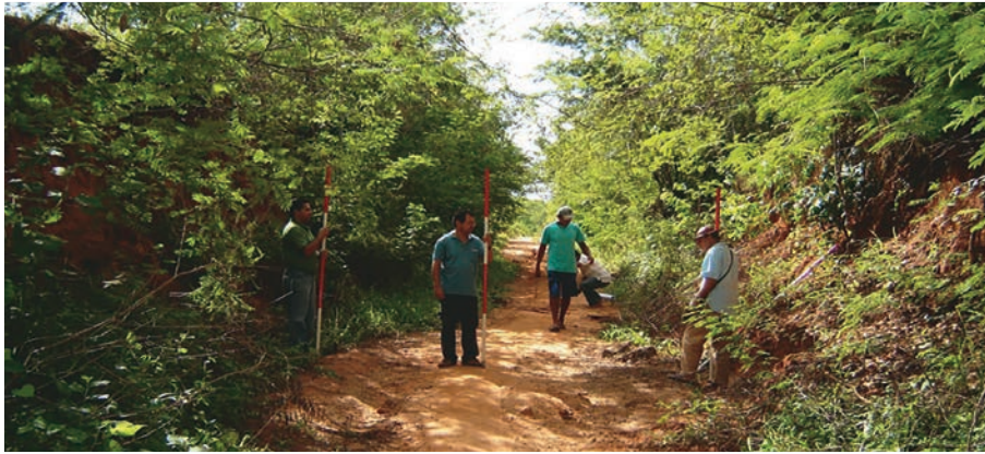
Foto 08 – Equipe técnica da Fundação Araripe locando o eixo da BBZ – 02, em função das características do riacho e do boqueirão. Observam-se as ombreiras argilosas abruptas, o leito de argila compactado, totalmente seco e a secção do boqueirão perpendicular a esse trecho do riacho. A altura da parede (cota de sangria) foi arbitrada em 1,00 m, a largura do coroamento em 0,30 m e 1:1 o talude de jusante.
