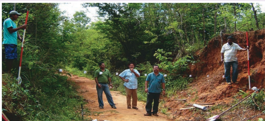
Foto 14 – Construção do compasso de campo: com balizas, nos piquetes B e B' (cotas de sangria) – ligadas por um arame esticado e na horizontal. Observam-se as bandeirolas para melhor visualização do raio do compasso, igual à corda do Arco Romano, do arco jusante e do vão da BBZ, no caso igual a 6,00 m.
