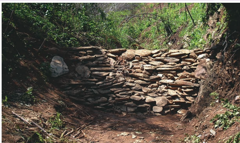
Foto 36.21 – BBZ concluída, vista de jusante. Observa-se o seu coroamento nivelado, o arraste da saia (arrimo) e os interstícios entre as pedras, que servirão de filtro das águas turvas, retendo a montante o barro, a lama e o limo, formando as férteis minivazantes.
