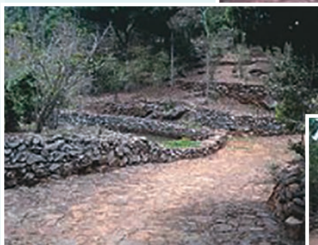
Foto 7 – Mureta de pedra seca em contorno, em antigo cafezal. Triunfo – PE. Observe-se os carreadores em nível paralelo as muretas. Crédito: Cerlit – PE
