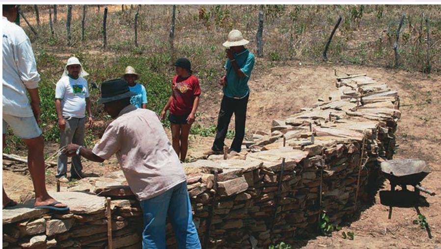
Foto 32.5 – Elevação do corpo da BBZ em alvenaria de pedra seca já concluída, vista da ombreira esquerda. Observa-se a parede de montante a prumo, com altura de 1,00 m, o coroamento com 0,50 m de largura, no nível do topo das estacas do arco de montante e o arraste da saia (arrimo), o consultor Geraldo Leal e os seis assentados construtores da BBZ. O seu formato em Arco Romano transfere as pressões hidráulicas exercidas no barramento para as ombreiras, dando a máxima estabilidade à obra, norma estabelecida por Arthur Padilha – ex-diretor do Dnocs – “o pai do Sistema BBZ”.
