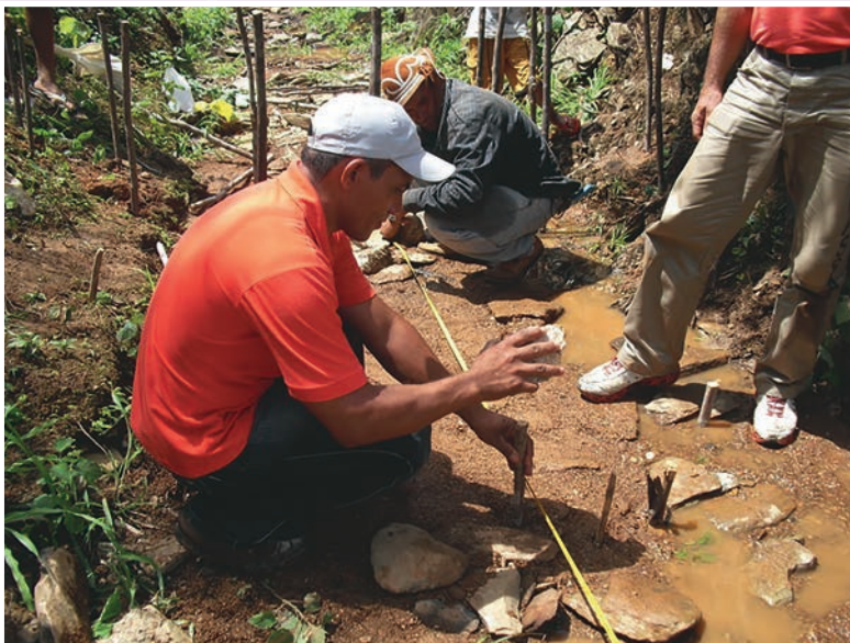
Foto 36.12 – Marcação do arraste da saia da BBZ, vista de outro ângulo. Observam-se as estacas niveladas dos arcos jusante e montante. Um assentado mede a altura da estaca – no caso um 1,00 m – e alinhado, com o centro geométrico da obra, marca o seu arraste, no caso duas vezes a altura, face ao talude adotado, ou seja, 2,00 m. Vulgarmente o arraste da saia da BBZ é denominado “arrimo”.
