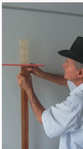
Foto 10.2 – Fixando na lateral da régua “A”, e a 7 cm do seu topo, a orelha esquerda “C”, de modo que as duas larguras se “casem”.
