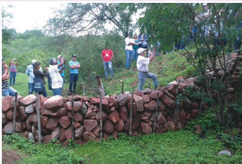
Foto 35 – BBZ concluída, vista do meio do riacho, a montante. Observa-se o seu coroamento nivelado pelos topos das estacas do arco montante e os interstícios para filtragem das águas turvas, retendo a montante o barro, a lama e o limo, formando as férteis minivazantes.
