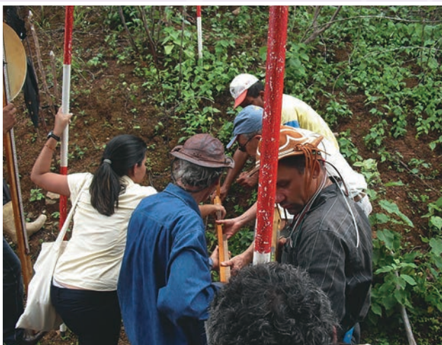
Foto 36.3 – Locação dos dois pontos de sangria, B e B', em ambas as margens, na cota 1. No presente caso, empregou-se a régua e “nível de pedreiro”, face à estreiteza do vão da BBZ, dispensando-se o nivelador de alvo.
