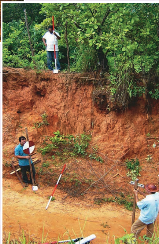
Foto 11 – Com o nivelador e mira de alvo, visando à ré o piquete 0 (cota zero) a fim de locar os piquetes B e B' (cotas de sangria), nas duas ombreiras, com desnível de 1,00 m, altura arbitrada para a BBZ. Observa-se o alvo a 1,40 m na escala da mira.
