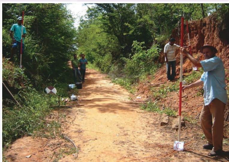
Foto 15 – Marcação do centro geométrico dos arcos a jusante do eixo da BBZ com o compasso de campo. O compasso de campo centrado alternadamente nos piquetes B e B' e raio igual à corda ou vão do arco, riscam o leito do riacho. O cruzamento dos dois riscos loca o piquete C ou centro geométrico dos arcos montante e jusante. Observa-se o arame esticado e na horizontal. Riacho do Lobo, Crato – CE. Foto: Francisco de Souza Nunes
