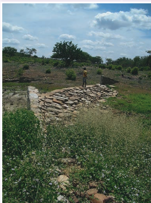
Foto 32.6 – BBZ já concluída, vista da ombreira esquerda a jusante. Observa-se o talude 2:1, do arraste da saia da BBZ, o consultor Geraldo Leal e os seis assentados construtores da obra.
