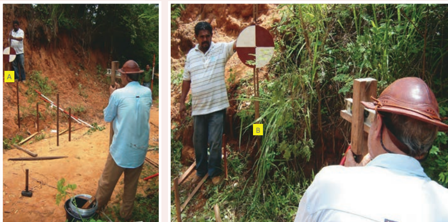
Foto 6.0 – Nivelamento simples entre os pontos “A” e “B”
