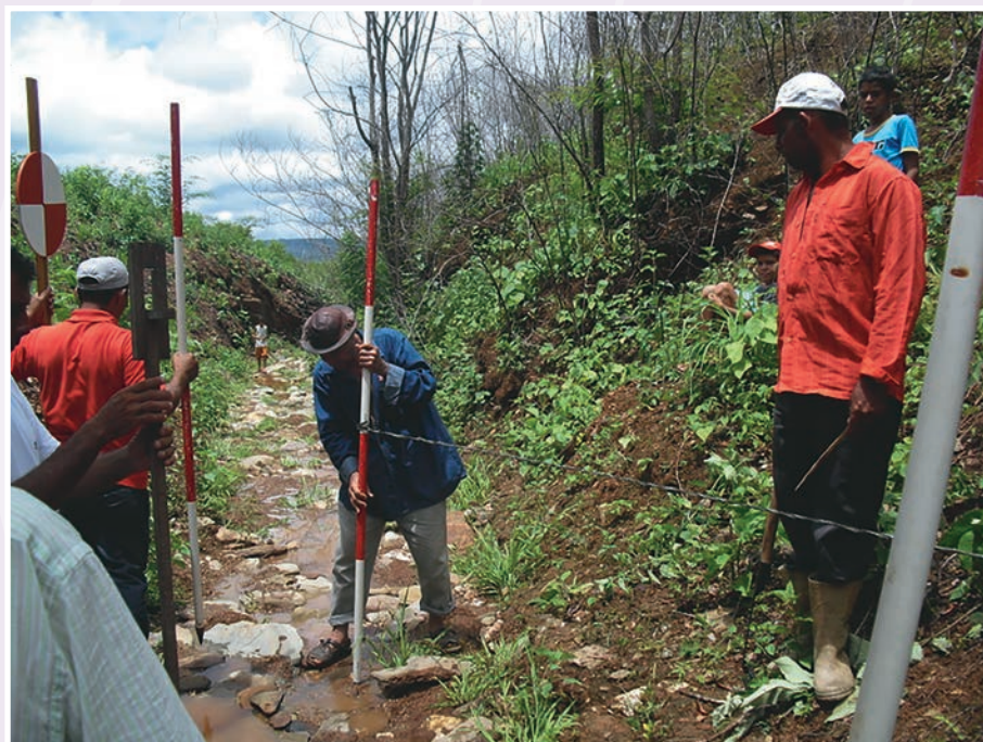
Foto 36.5 – Marcação do centro geométrico da obra, por meio do compasso de campo, cujo raio é igual ao vão da BBZ, ou seja, a distância horizontal entre os dois pontos de sangria: B e B. Observa-se o consultor Geraldo Barreto, "riscando" o leito do riacho, a jusante do eixo da BBZ, com uma das balizas, e o fitilho que é o raio do compasso, ligado a outra baliza no ponto de sangria B, na margem direita.
