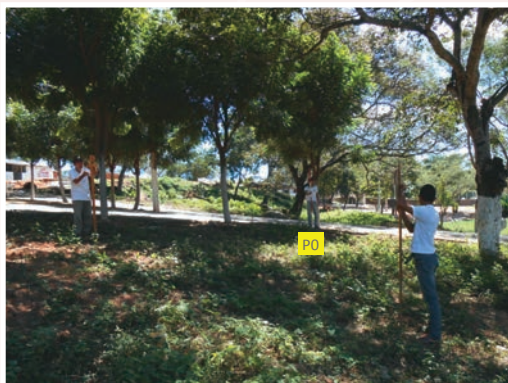
Foto 7.3 – Locação do próximo piquete da curva de nível, “P1”. O porta-mira, com o alvo anteriormente fixado, sobe ou desce a encosta até o operador enquadrar o alvo. Ao fundo se vê um balizeiro posicionado no piquete inicial, “P0”, e, à esquerda, o operador com o nível de alvo estacionado.
