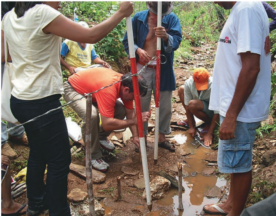
Foto 36.8 – Marcação dos arcos jusante e montante, através de piquetes provisórios. Observa-se o fitilho, com comprimento igual ao vão da BBZ, e do raio do compasso, no caso 3,80 m. Uma das balizas do compasso estacionada no centro geométrico da obra, e a outra baliza marca os piquetes provisórios do arco jusante, de metro em metro. Por visada nos piquetes do arco jusante, já locados, para o centro geométrico, marca-se os piquetes provisórios do arco montante, acrescido da largura do coroamento, no caso 0,50 m.
