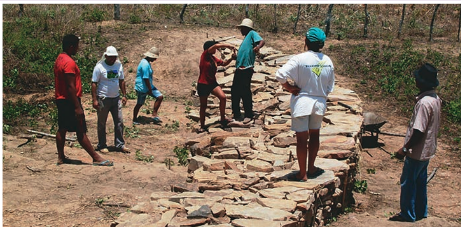
Foto 32.4 – Elevação do corpo da BBZ em alvenaria de pedra seca, vista da ombreira esquerda. Observa-se a parede de montante a prumo e o arraste da saia (arrimo), o consultor Geraldo Leal e os seis assentados construtores da BBZ.
