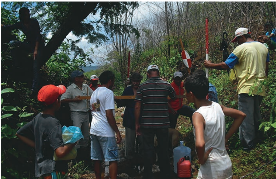
Foto 36.2 – Locação do eixo da BBZ, perpendicular ao fluxo das águas, através de dois piquetes nas margens do Riacho. Observa-se o angico, na margem esquerda, que deu nome ao local, os assentados que construíram a obra e a equipe técnica da Fundação Araripe.
