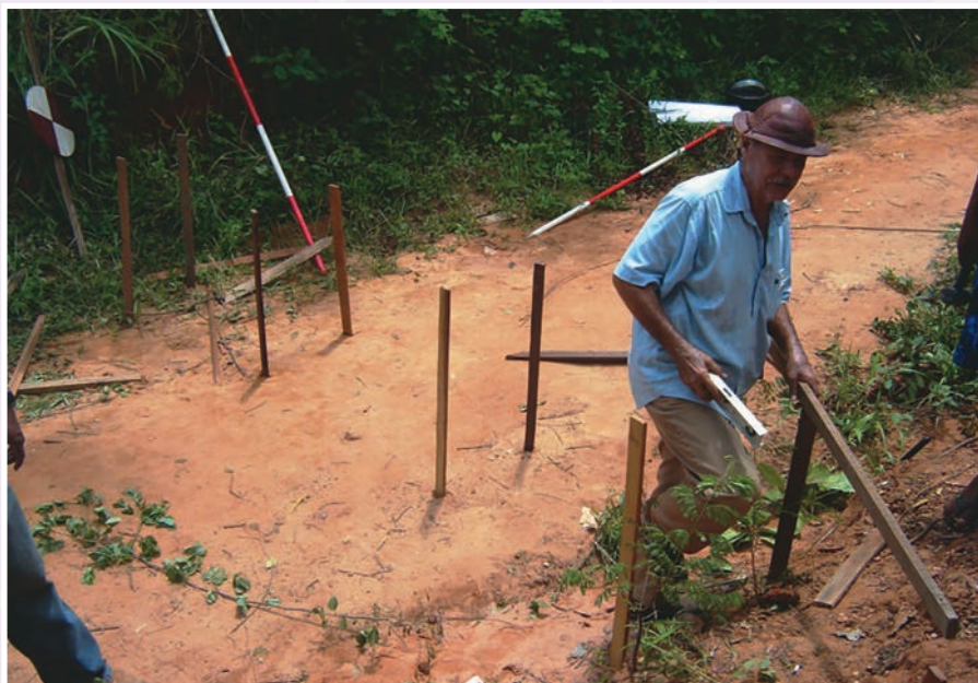
Foto 24 – Vista geral – de jusante para montante – de pares de estacas, verticalizadas e niveladas, na cota de sangria, dos arcos montante e jusante e alinhadas radialmente em relação ao piquete C. Riacho do Lobo, Crato – CE. Foto: Francisco de Souza Nunes
