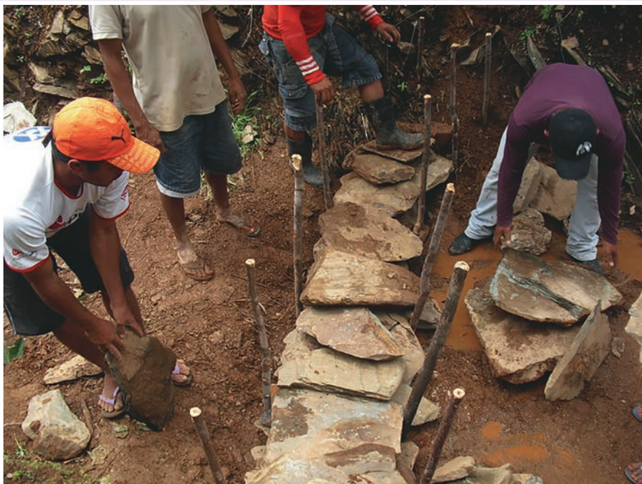
Foto 36.18 – Início da elevação do corpo da BBZ, em alvenaria de pedra seca, vista da ombreira direita. Observa-se o início da construção da mureta e do arraste da saia, orientado pelas estacas dos arcos montante e jusante.
