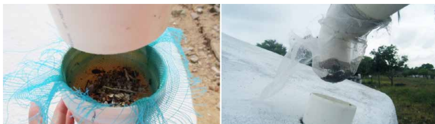
Figura 48 - Fotos de las dos redes de las cisternas escolares después de las lluvias.
