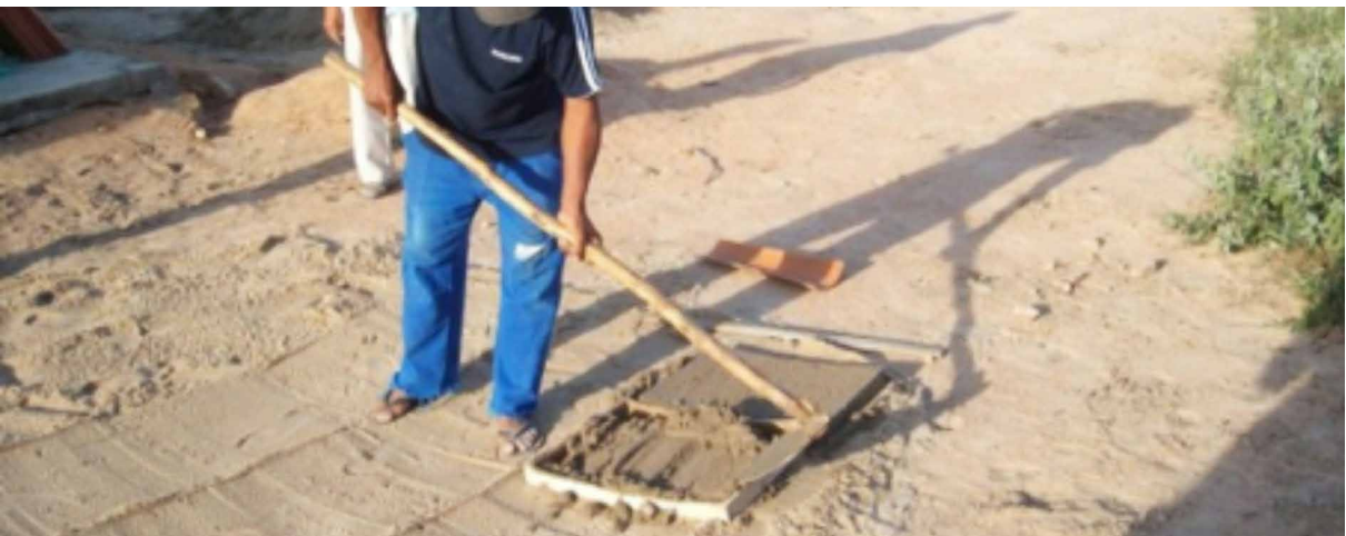
Figura 11 - Fabricación de las placas de la pared de la cisterna
