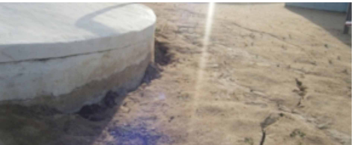
Figura 17 - Estado de la cisterna de Povoado Pedrão tras la realización de la prueba hidráulica.
