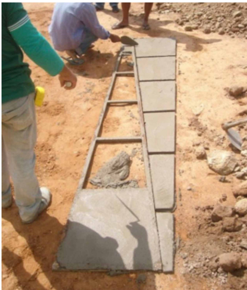
Figura 13 - Fabricación de las piezas de la cubierta.
