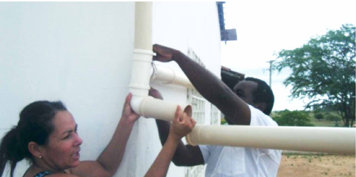
Figura 24 - Retirada manual de las primeras aguas.
