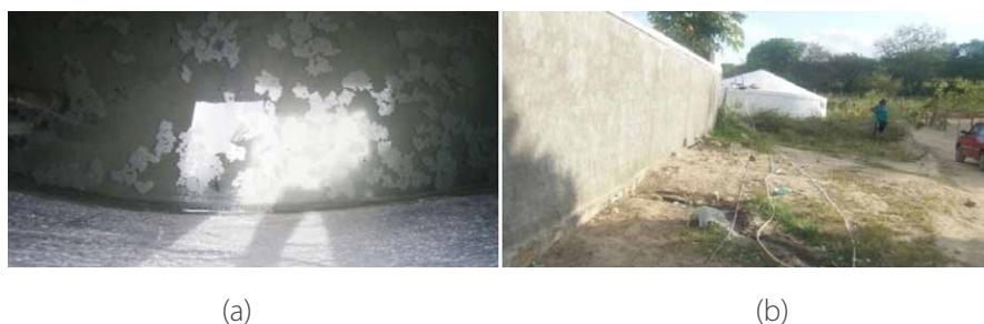
Figura 47 - Fotos de las cisternas CONDRI: (a)- agua con cemento y (b)- vaciado del agua de la cisterna.
