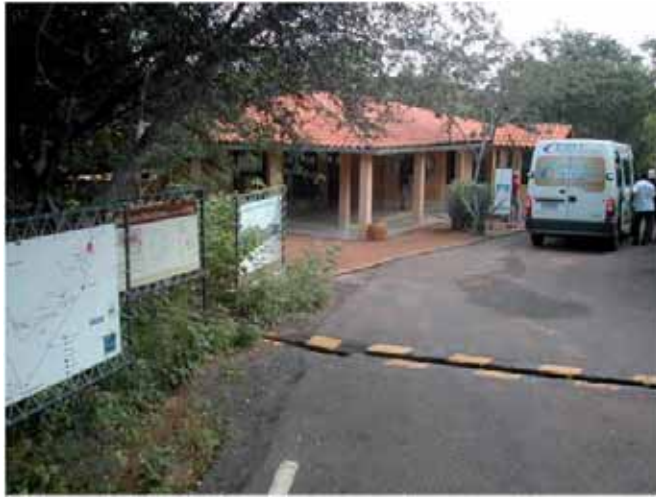
Figura 8. Ponto de acesso ao Parna-SC. Informações, venda de ingressos e loja
