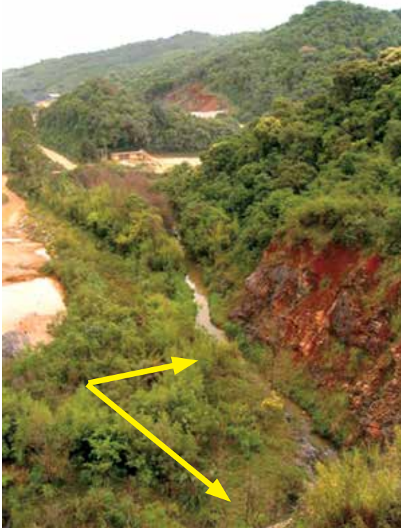
Figura 5.7: Rio Bacaetava, no Paraná, onde as setas mostram trechos da Gruta Escura destruídos e a redefinição do leito do rio.
