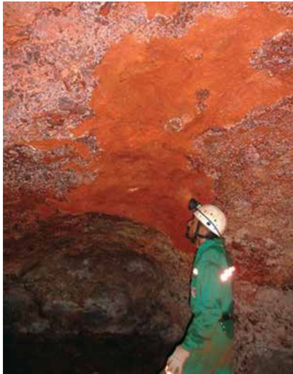
Figura 5.8 e 5.9: Na esquerda, caverna em frente de lavra ao norte do Distrito Federal, em Goiás. Na direita, caverna em minério de ferro próxima à frente de lavra na região de Carajás-PA. Em ambas, notar a diferença de cor entre a rocha sã e as rachaduras nas paredes da caverna.
