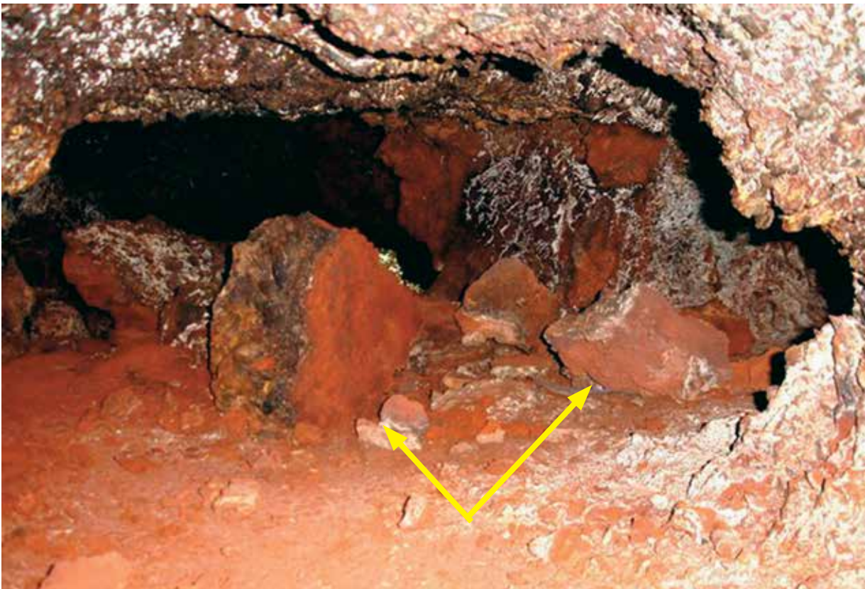
Figura 5.10: Caverna em minério de ferro na região de Carajás-PA, nas proximidades de uma frente de lavra paralisada. Notar a sucessão de blocos abatidos do teto, e diferenças de cor entre a rocha sã e as paredes da caverna.
