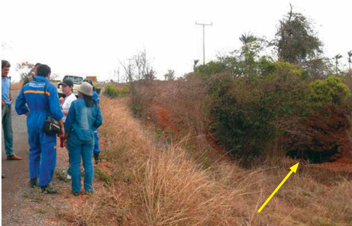
Figura 5.22: Esta foto mostra a proximidade entre a entrada da Gruta da Fumaça (seta), em Iraquara-BA e a BR-122 (espeleólogos). A estrada foi construída sobre trechos significativos da caverna.
