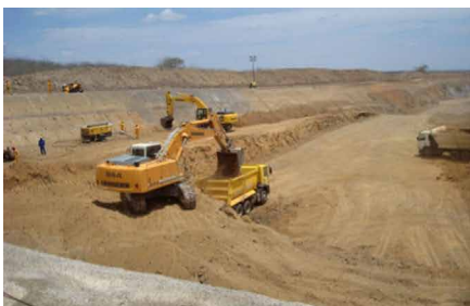
Figura 47 - Canal do Sertão - Detalhe da escavação do solo.
