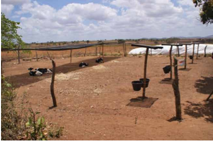
Figura 33 - Instalações para bezerros em aleitamento.
