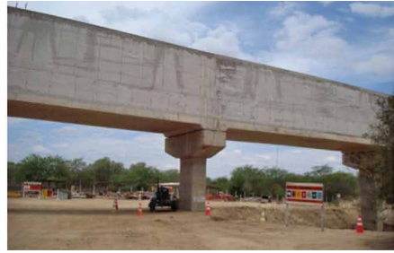
Figura 50 - Canal do Sertão - Ponte canal.
