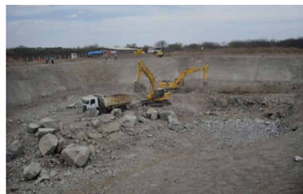
Figura 48 - Canal do Sertão - Detalhe da escavação de rochas.
