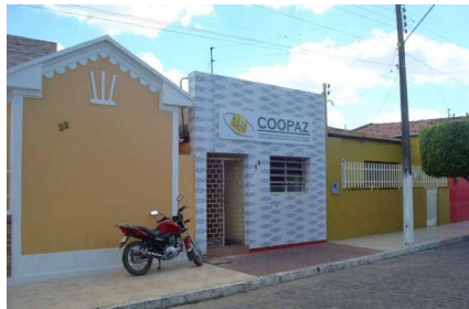
Figura 42 - Detalhe da sede da COOPAZ.
