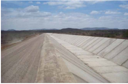
Figura 49 - Canal do Sertão - Detalhe do trecho já concluído.
