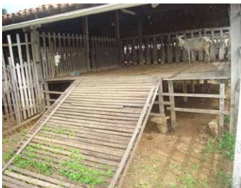
Aprisco suspenso – piso ripado de madeira
