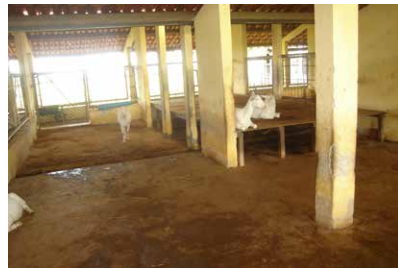
Aprisco de piso de concreto, contendo uma parte de piso suspenso
