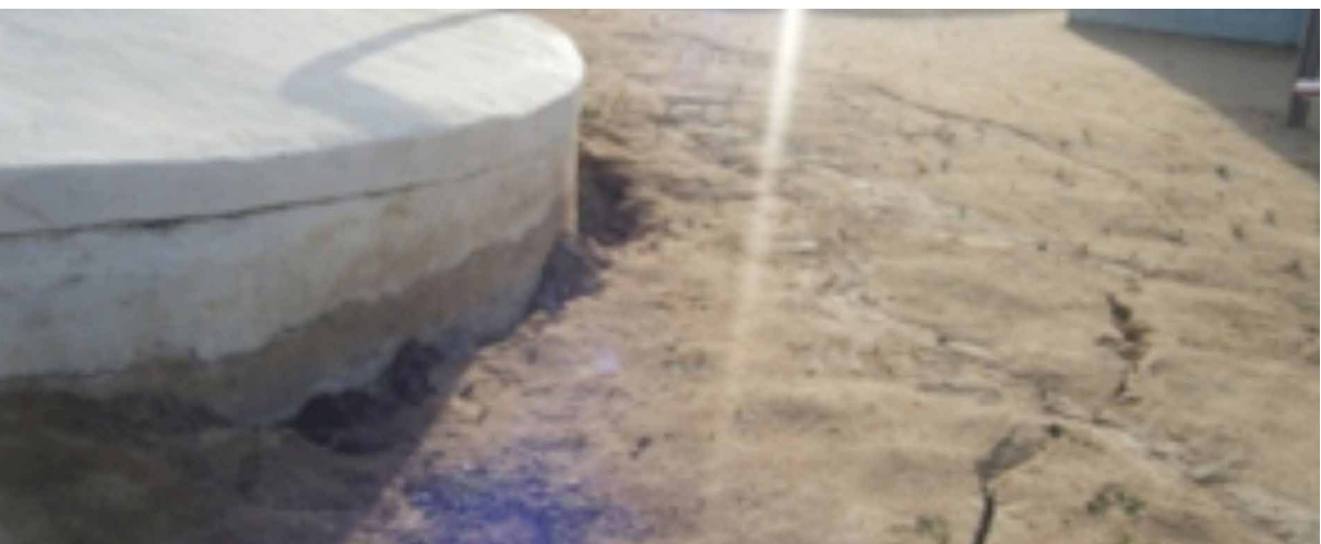
Figura 17 - Estado da cisterna de Povoado Pedrão após a conclusão do teste hidráulico.
