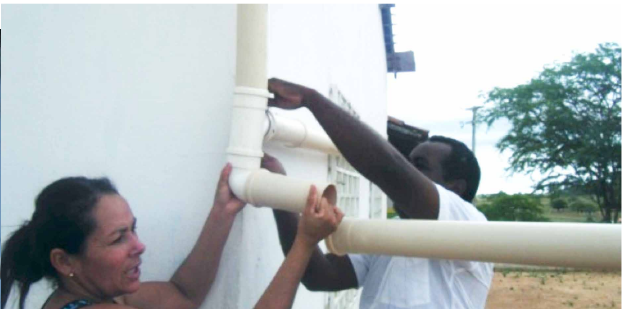
Figura 24 - Retirada manual das primeiras águas.
