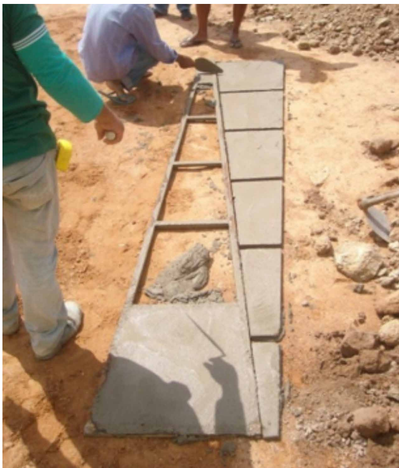
Figura 13 - Fabricação de partes da cobertura.
