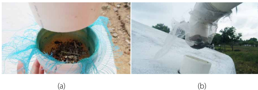
Figura 48 - Fotos das duas redes das cisternas escolares após as chuvas.
