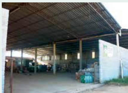
Figura 37. Central de Armazenamento e Comercialização da Rede Cata Vida.
