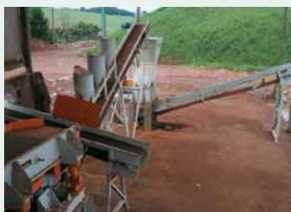
Figura 28. Equipamento de beneficiamento de plástico.
