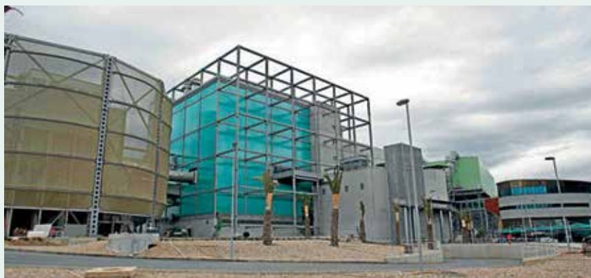
Figura 91 - Plataforma de Valorização energética de Mallorca
