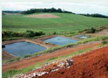
Figura 30. Lagoas de tratamento de lixiviado.
