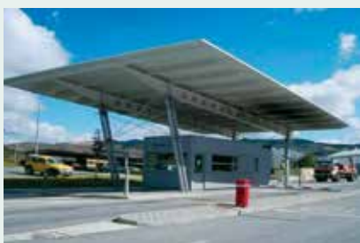
Pesagem de caminhões na entrada do aterro
