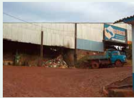
Figura 22. Galpão de triagem do CIGRES.
