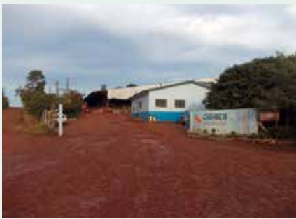
Figura 21. Vista da sede do CIGRES.
