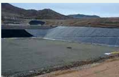
Cobrimento dos resíduos com terra
