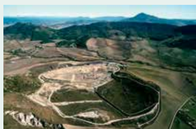
O aterro sanitário é organizado em celas que vão se preenchendo de maneira sequenciada
