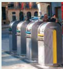
Parque de contêineres soterrados em zonas históricas. Pamplona
