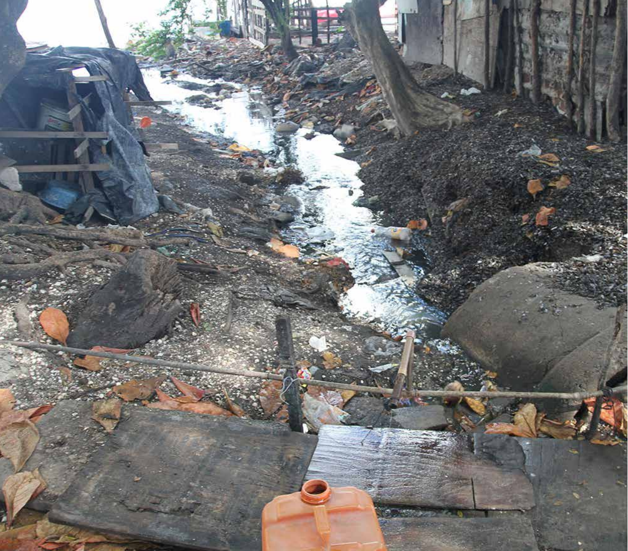
Figura 5 – Canal de esgoto lançado diretamente na lagoa Mundaú
