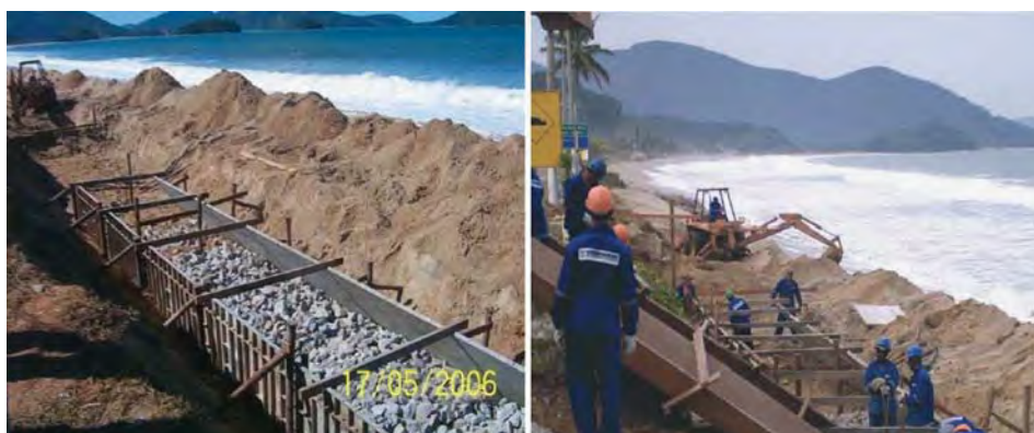
Figura 5 – Construção do muro de contenção de 500 metros na praia de Massaguaçu
