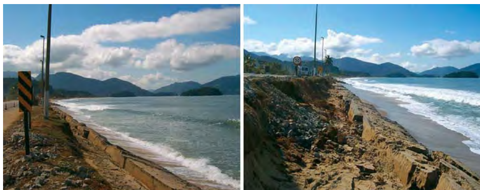
Figura 6 – Solapamento do muro de contenção em 2006
