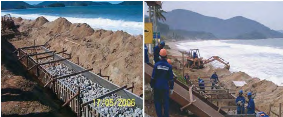
Figura 5 – Construção do muro de contenção de 500 metros na praia de Massaguaçu
